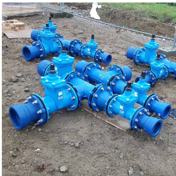
Pour garantir la sécurité lors des raccordements ROUSSEAU ATLANTIQUE prépare hors tranchée les montages.
