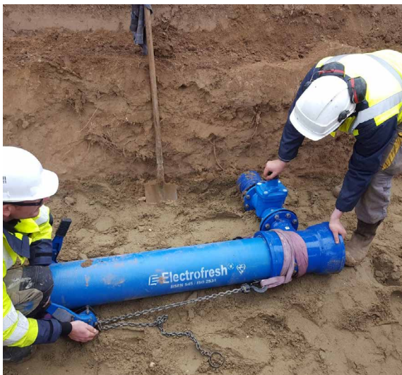
Pour faciliter le montage des raccords, démonstration d'emplois de palans.
