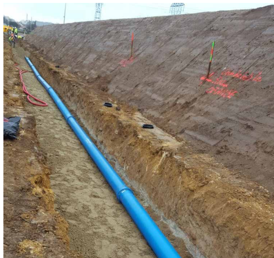
La largeur de tranchée favorise la propreté des mises à joints.
